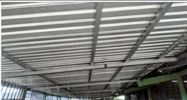
Foto 3: Lámina troquelada aluzinc calibre 26 y soporte de metal
