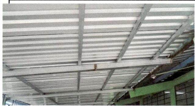
Foto 4: Lámina troquelada aluzinc calibre 26 y soporte de metal
