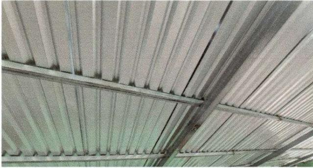
Foto 1: Lámina troquelada aluzinc calibre 26 y soporte de metal
