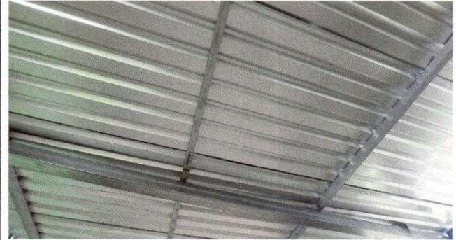
Foto 2: Lámina troquelada aluzinc calibre 26 y soporte de metal
