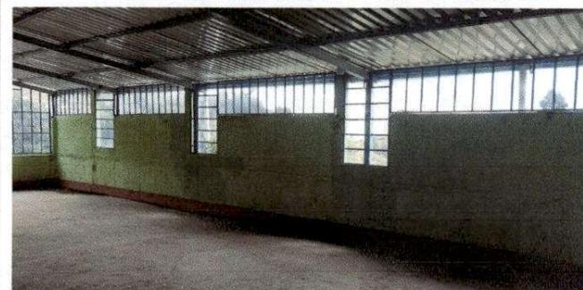
Foto 6: Lámina troquelada aluzinc calibre 26 y soporte de metal
